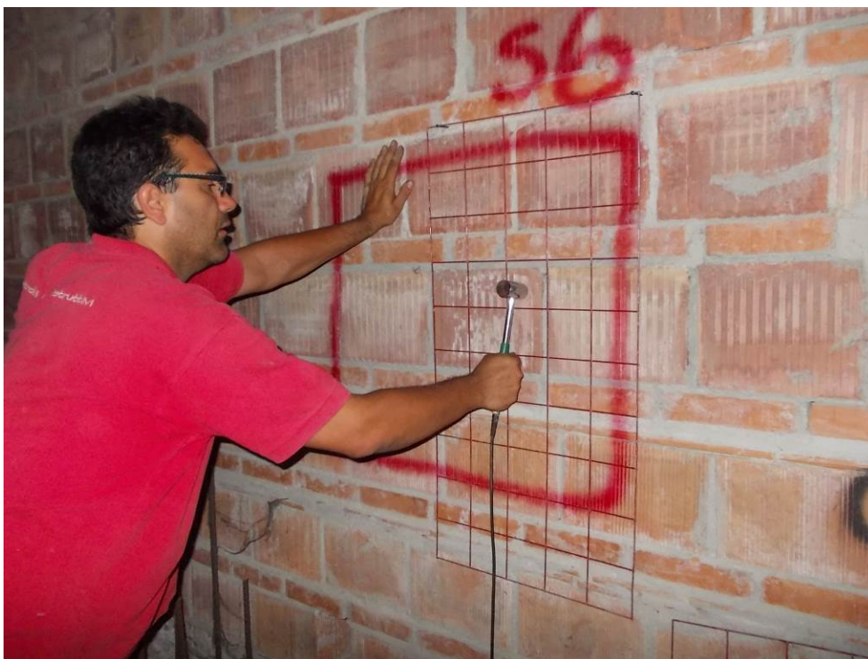
Indagine sonica eseguita nella zona rifatta.
