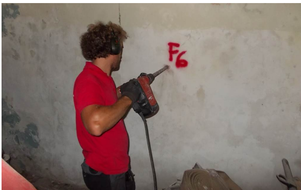
Zona F6 – esecuzione foro di ispezione.
