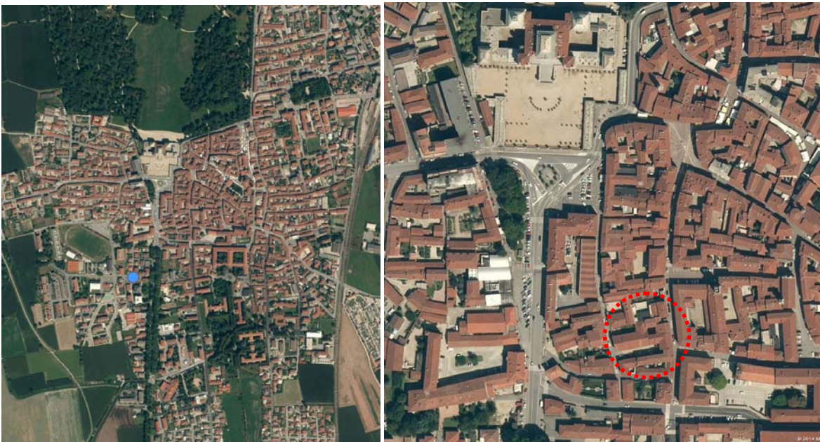
Stralcio foto aerea con visualizzazione dell'area interessata (da Google Earth con visualizzazione dell'area di interesse).
