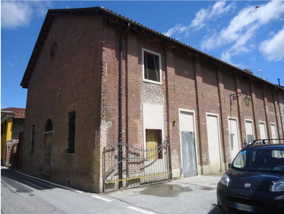
Figura 2 – Facciata Ovest prospettante Via Carlo Costa
