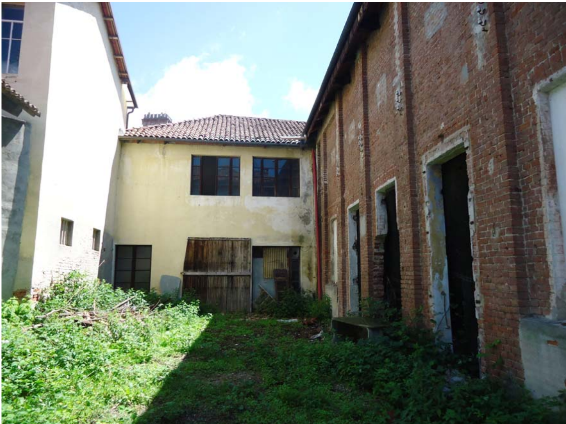
Figura 5 – Facciata Nord ex salone sociale su cortile interno accessibile da Via Carlo Costa e facciata Ovest del fabbricato accessorio
