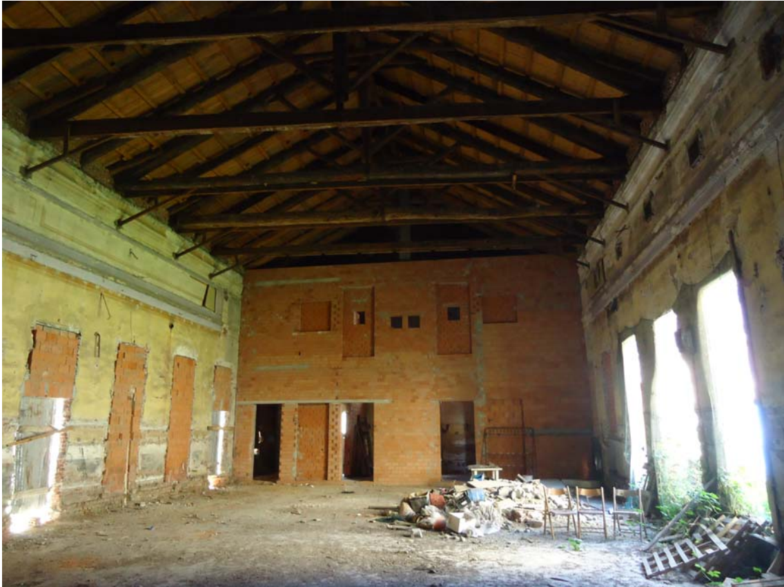
Figura 6 - Interno ex cinema sociale in seguito all'esecuzione dei lavori di ristrutturazione incompiuti dalla S.O.M.S.
