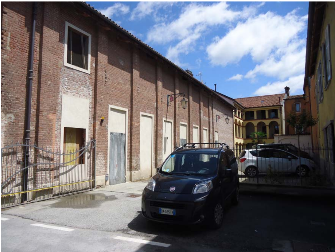
Figura 3 – Facciata Sud prospiciente il collegamento pedonale tra Via Levis e Via Carlo Costa
